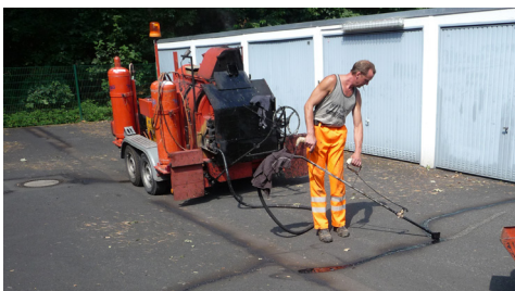
10 RISSANIERUNG (HPS)
